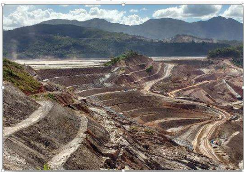
Figura 23 – Construção de berma de equilíbrio na barragem de Germano
